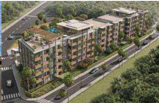
Tropics Residences: Proyecto de 50 aptos. en construcción en La Vega.
